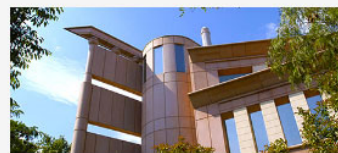
Building 3 - Av. Esplugues
