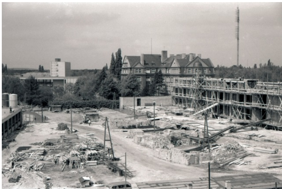
Baustelle für den Neubau der Juristischen Fakultät (re.) und der Wirtschafts- und Sozialwis- senschaftlichen Fakultät (li.), aufgenommen 1958.
