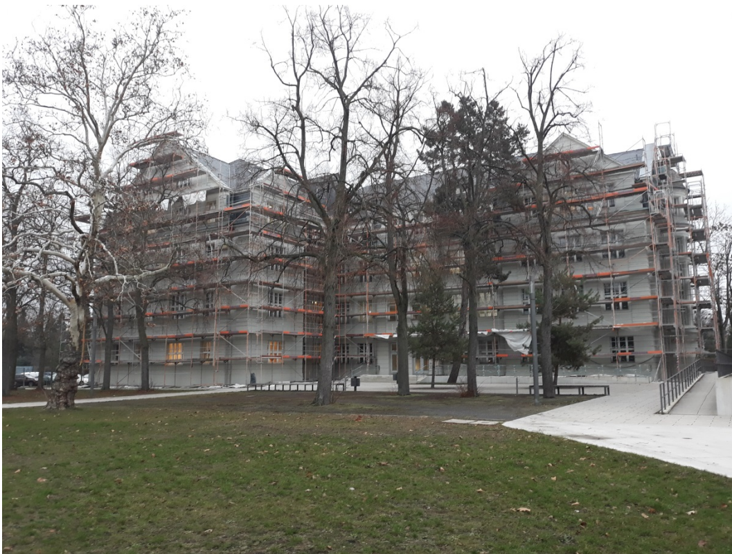
Fakultätsgebäude Boltzmannstraße 3 im Dezember 2018 – eingerüstet im Dienste denkmalschutzgerechter kunstvoller Restaurierung
